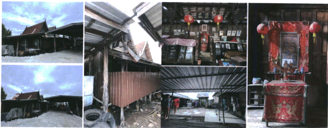
ภาพที่ 2 แสดงสภาพภายนอกและภายใน เรือนนายเซ่ง (จางเหยียนเซ็ง) อายุกว่า 130 ปี ที่มา: คณะผู้วิจัย
